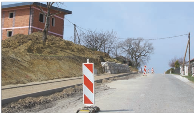
Investicijo v modernizacijo cestnega odseka na cesti Cerkevnik–Sveti Jurij ob Ščavnici ter v izgradnjo pločnika ob njej, ki so jo začeli izvajati lani jeseni, letos spomladi nadaljujejo.
