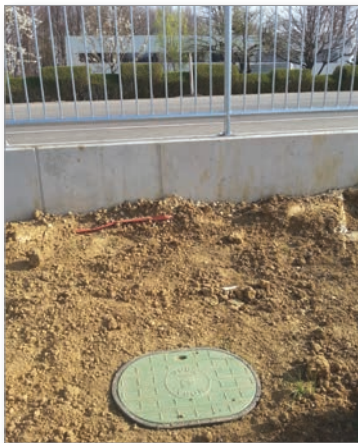
Vgrajen novi vodomerni jašek
