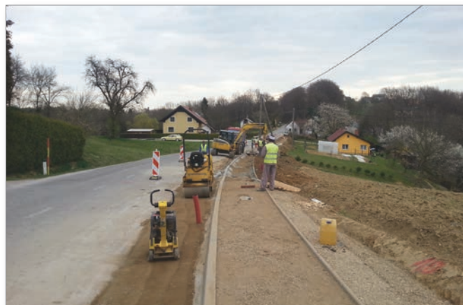
Izgradnja pločnika na zadnjem delu odseka
